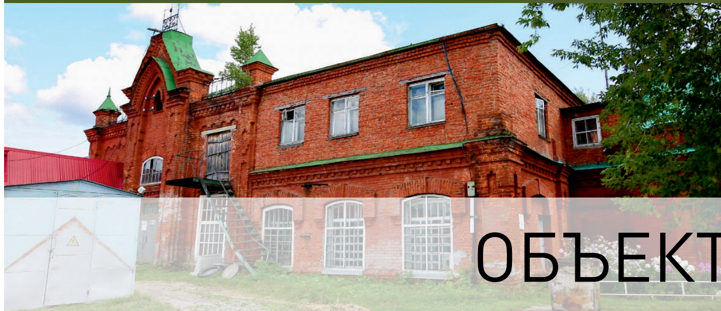
Внешний вид объекта
