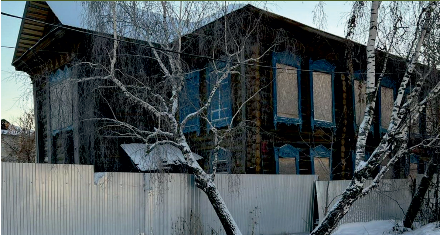
Внешний вид объекта
