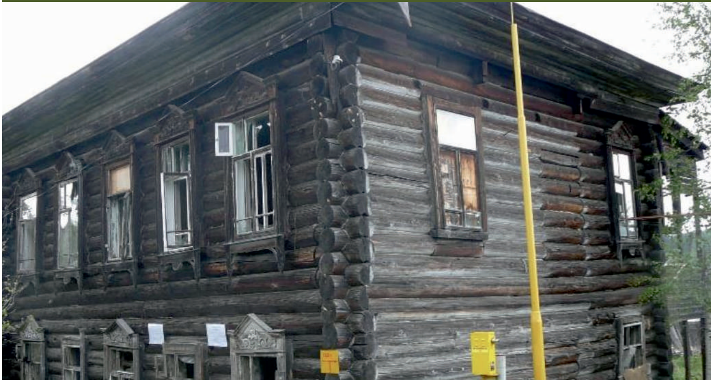
Внешний вид объекта
