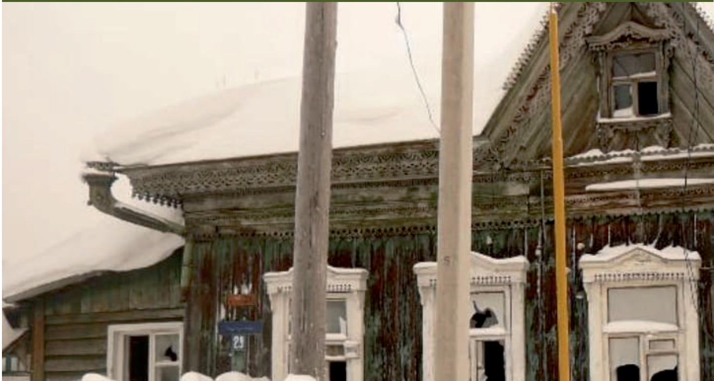
Внешний вид объекта
