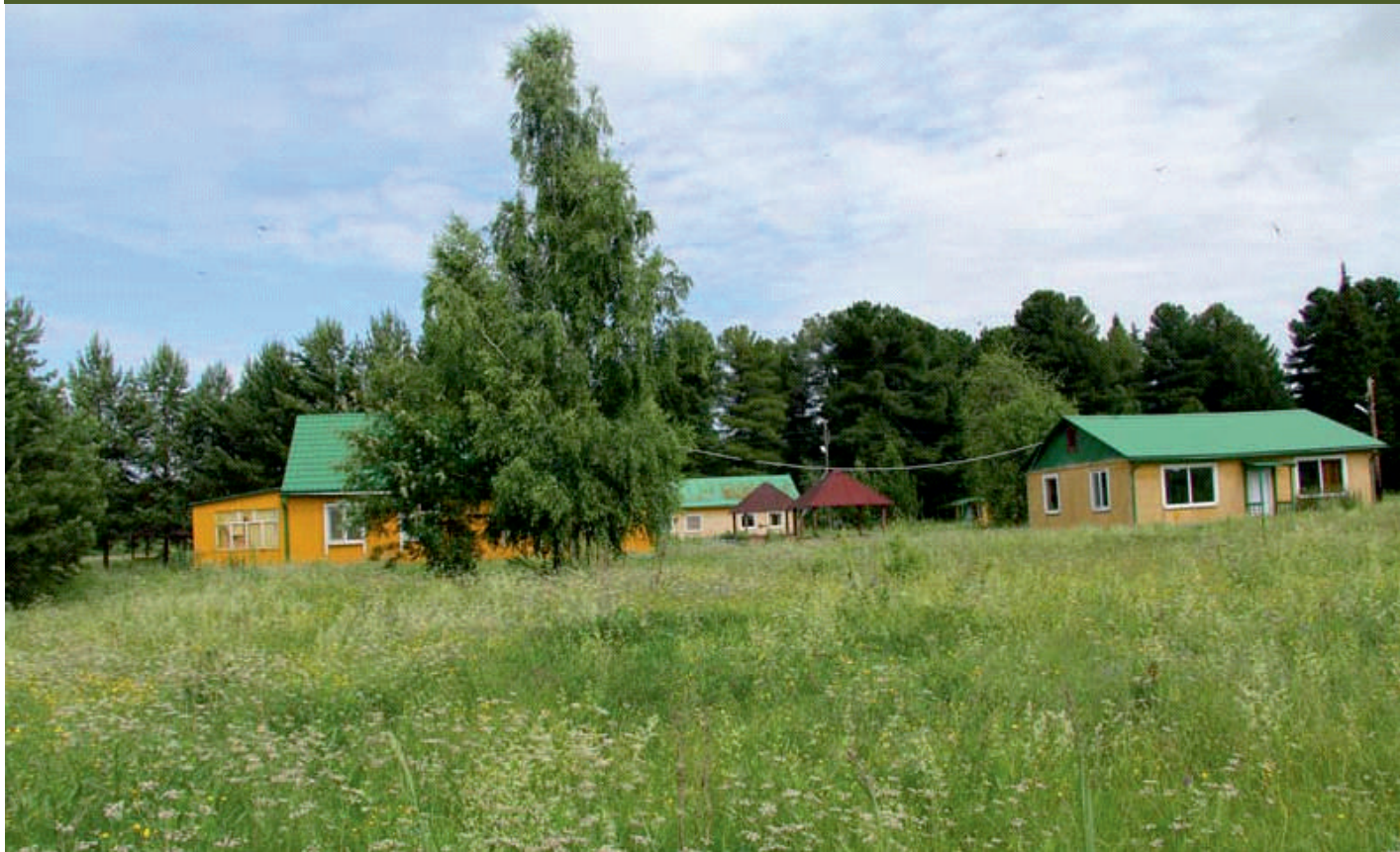
Внешний вид объекта
